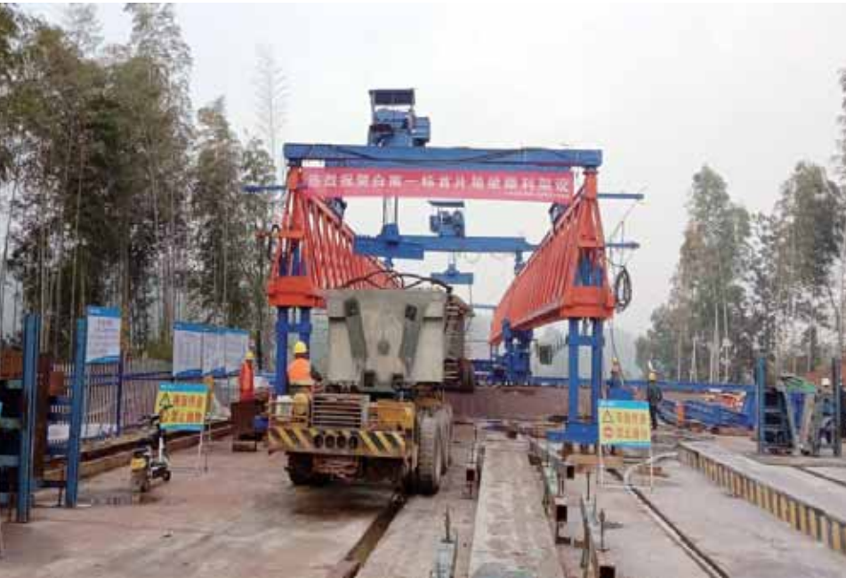
白南高速公路第一合同段 2# 预制梁场。
