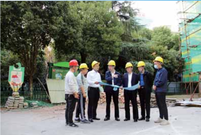
到市政协办公楼维修改造项目现场指导。
