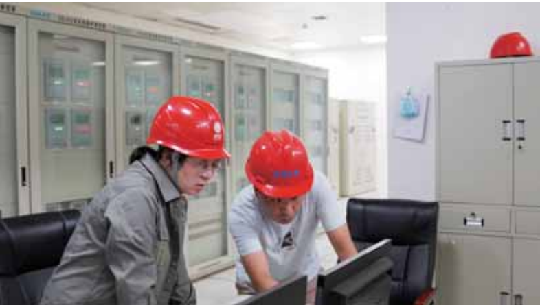
走访甘溪水电厂，协助开展安全隐患排查。 ■张雁 摄
