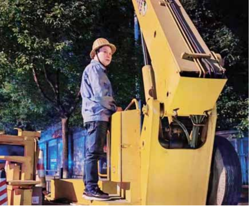
周小腾操控高空作业车协助工作人员进行路灯检修作业。
