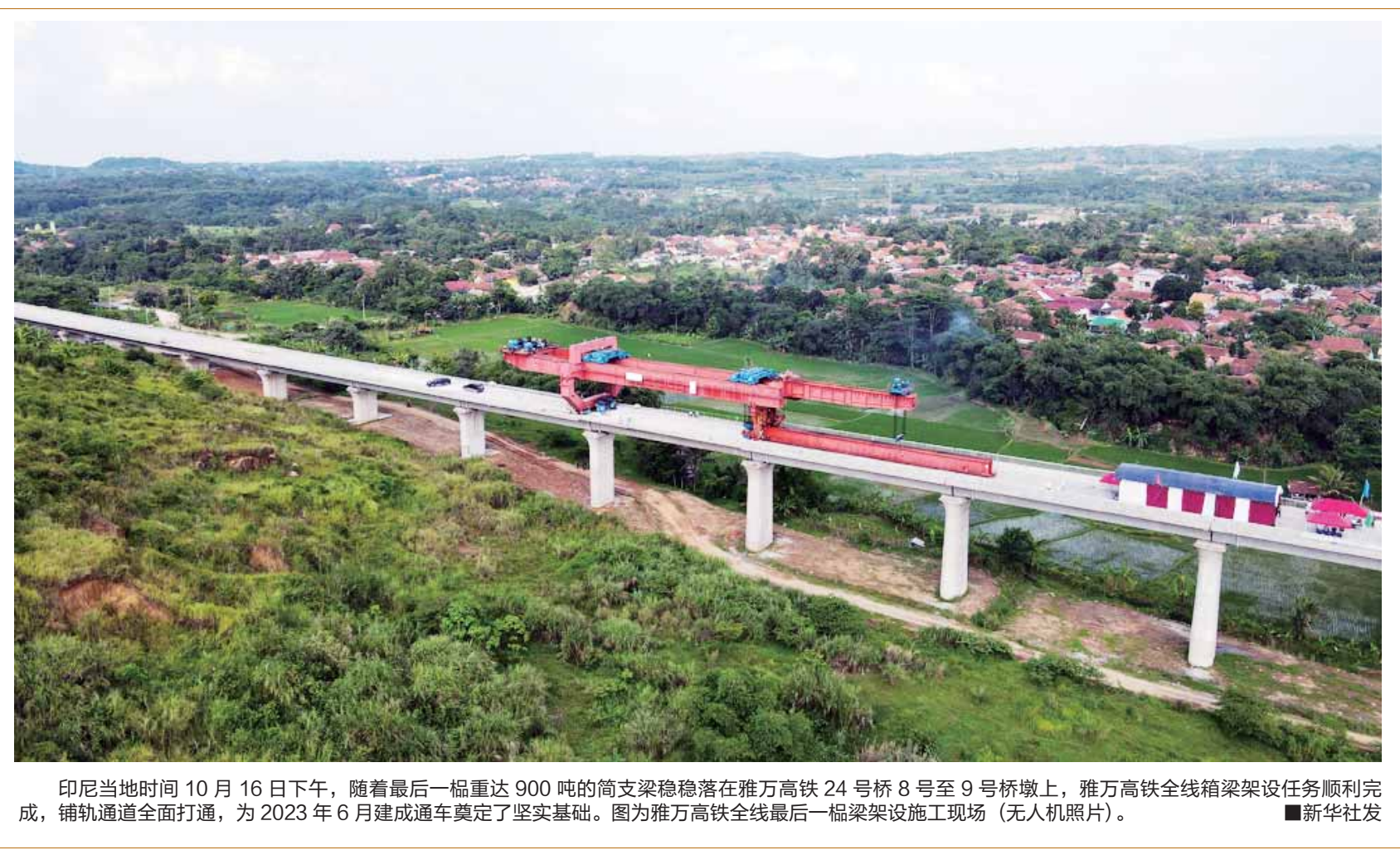
印尼当地时间 10 月 16 日下午，随着最后一根重达 900 吨的筒支梁稳稳落在雅万高铁 24 号桥 8 号至 9 号桥墩上，雅万高铁全线箱梁架设任务顺利完成，铺轨通道全面打通，为 2023 年 6 月建成通车奠定了坚实基础。图为雅万高铁全线最后一根梁架设施工现场（无人机照片）。 ■新华社发
