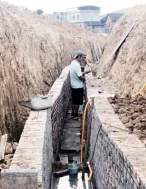
村民正在抢抓时间修建沟渠。
