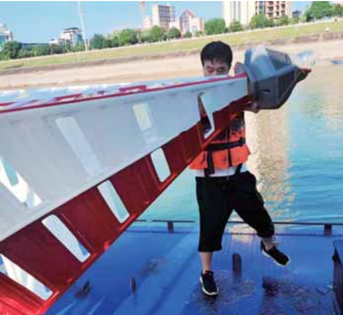
航道工作人员维修保养航标灯。
