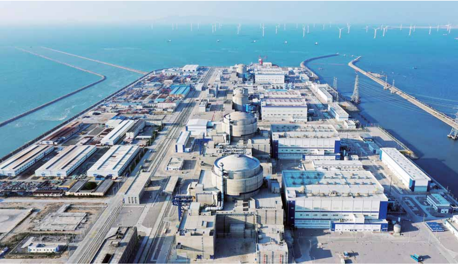
福清核电机组外景 (2021年12月1日摄,无人机照片)。■新华社发
