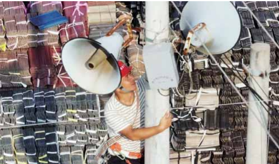
运维人员顶着烈日检修设备。
