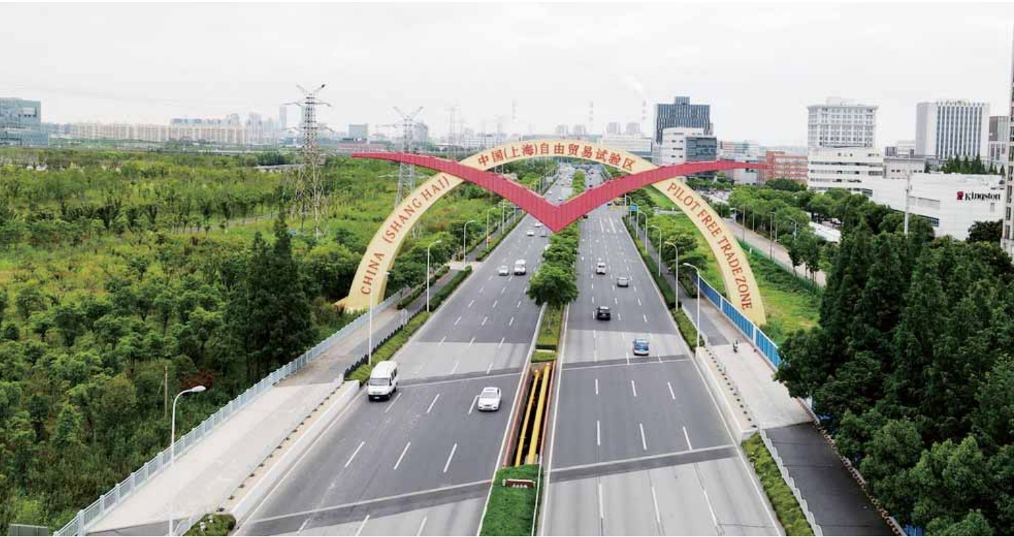
这是位于上海外高桥保税区的中国（上海）自由贸易试验区标志“海鸥门”（6月21日摄，无人机照片）。■新华社发
