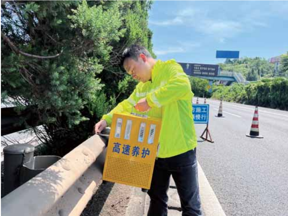
技术员安装便携式“声光”报警器。
