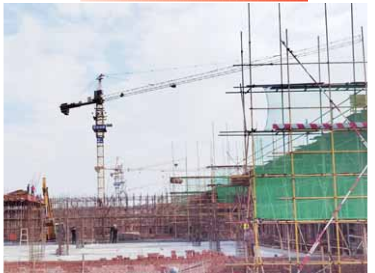
湘南纺织产业基地厂房基础施工已全面完成。
