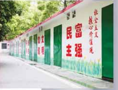
龙山里小区煤房改造后。
