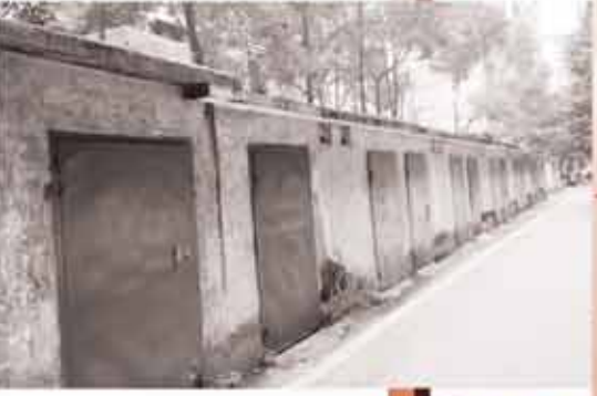
珠晖区龙山里小区煤房改造前非常破旧。
