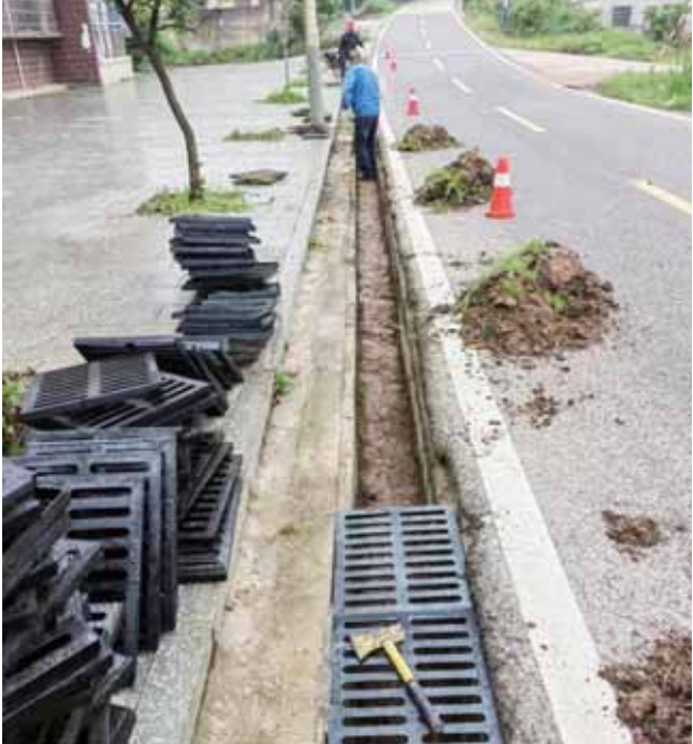
4 月以来接连出现强降雨天气，衡南县近尾洲镇路边沟边沟遗留了大量落叶和淤泥。为保障排水畅通，提升路域环境整体形象，该镇立即开展清理。目前，全镇累计清理边沟 1050 米，新铺(含加固)排水沟盖板 1590 块。 ■康康泽 摄
