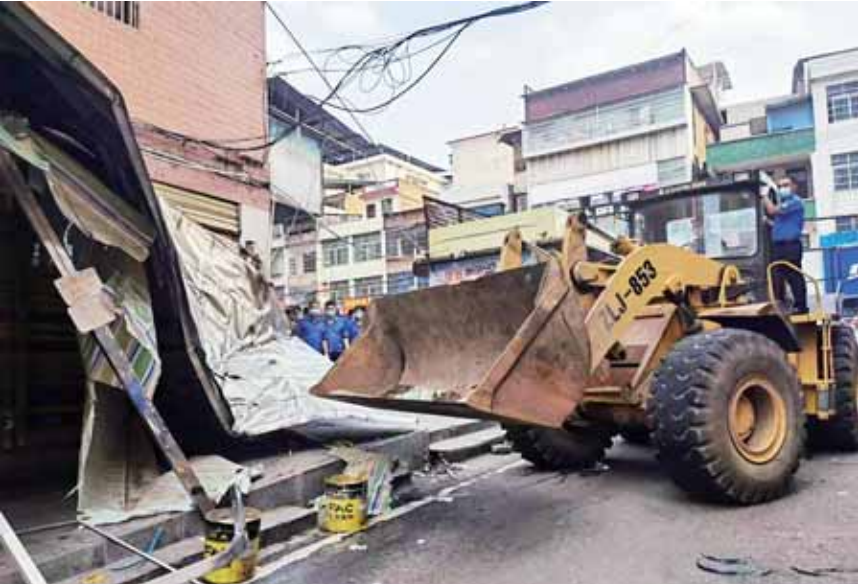
拆除违规搭建的摊棚。
