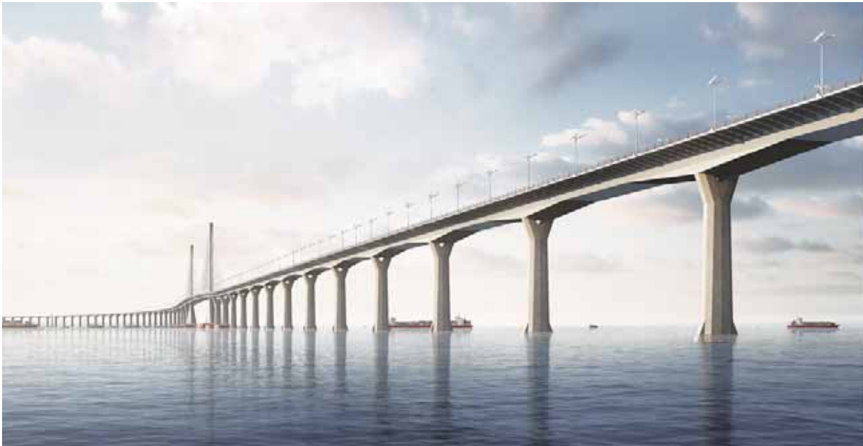
衡钢流体管被指定应用于港澳大桥拱北隧道。
