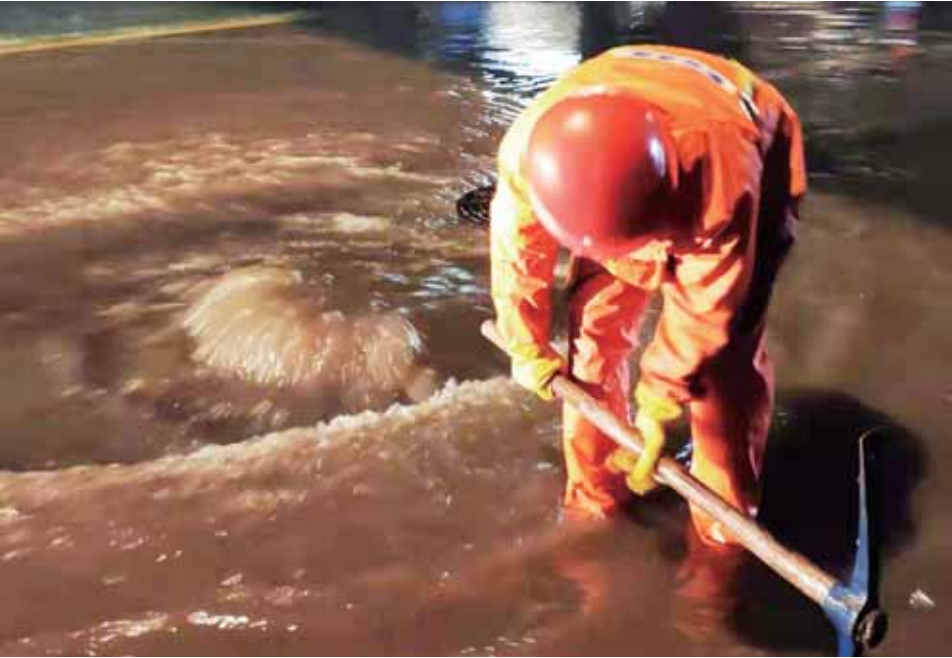
掀开井盖，加快排泄路面积水。
