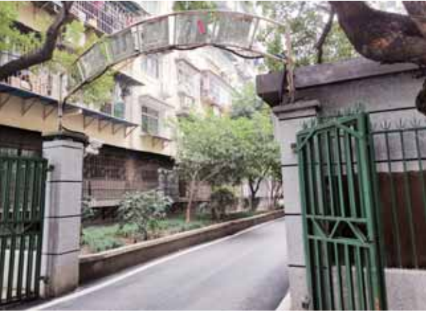
龙山里小区进门道闸改造前。
