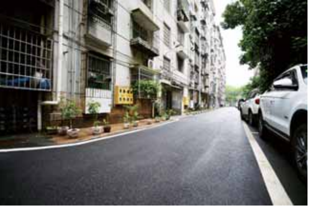
完成道路硬化。
