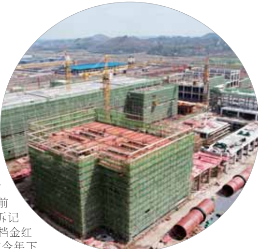
玉兔钛业正抢抓建设进度争取早日投产。
