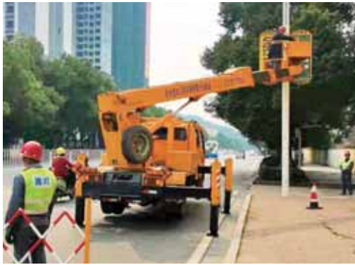
工作人员对违规寄杆广告牌进行拆除清理。
