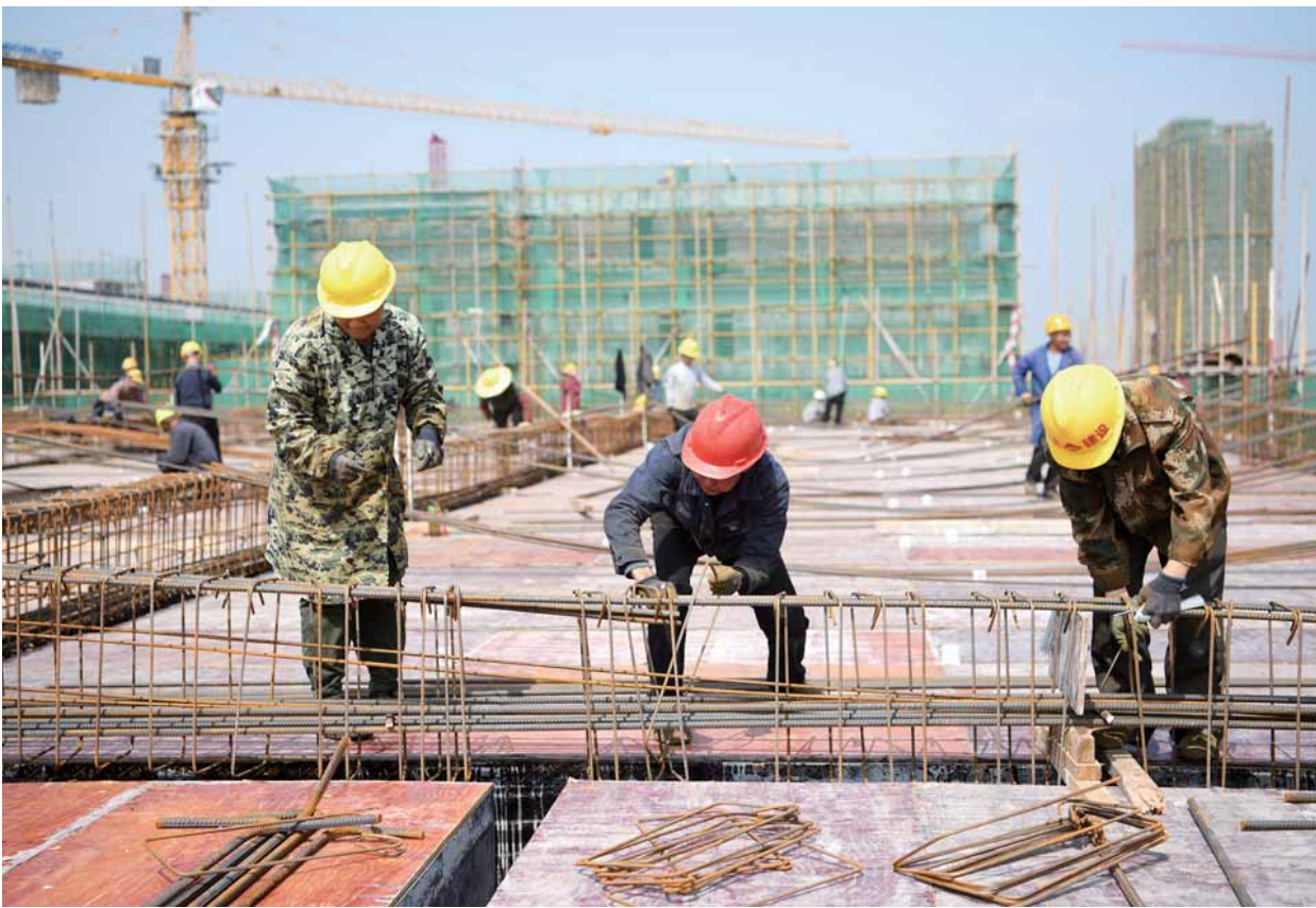
3月28日，在衡阳县“船山时间谷”·钟表产业园项目一期建设工地上，工人们正在扎钢筋。 ■钟仲华 摄
