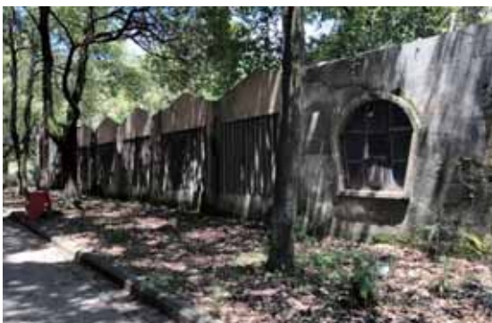
衡纺机老旧小区电动车停车棚改造前。
