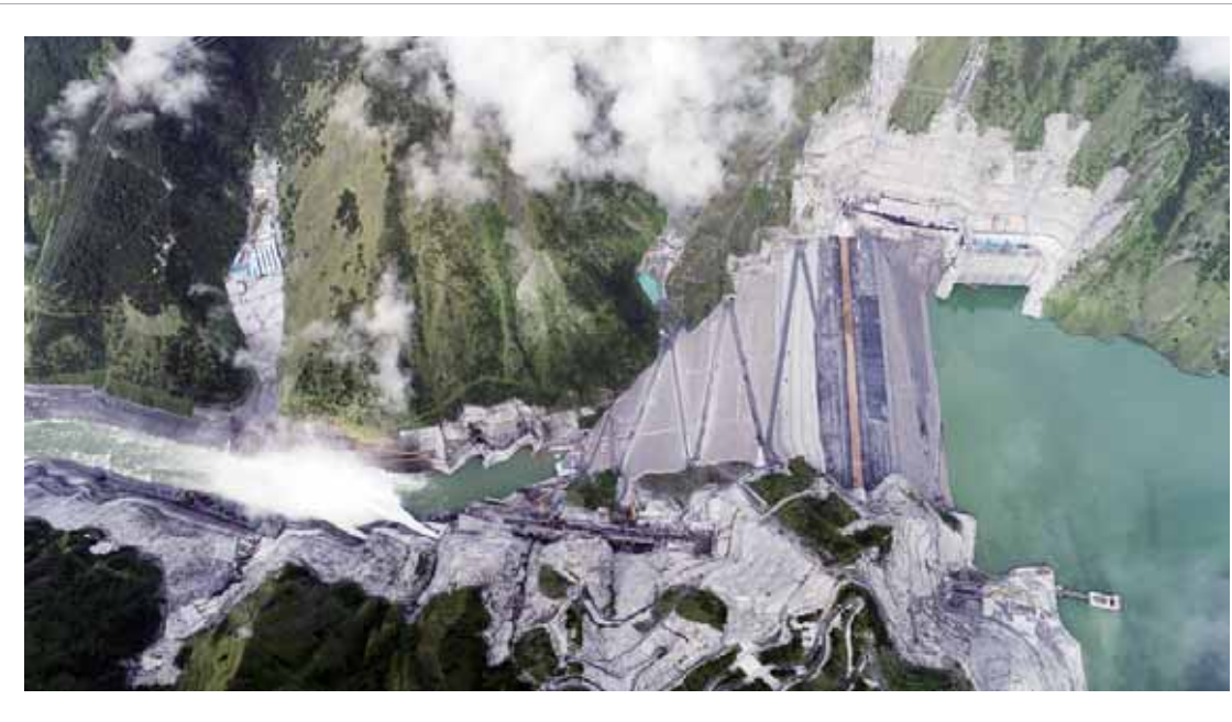
3月18日,我国海拔最高的百万千瓦级水电站——雅砻江两河口口水电站最后一台机组完成72小时试运行,正式投入商业运行。至此,两河口水电站6台50万千瓦机组全部投产发电。两河口水电站位于四川甘孜藏族自治州雅江县,是国家和四川省重点工程、西部大开发优化能源供给侧结构性调整的战略工程。核准投资总额664.57亿元,总装机300万千瓦,电站库容108亿立方米,具备多年调节性能。电站设计年发电量超过110亿千瓦时。于2014年10月开工,计划于2023年全部竣工。图为2021年9月1日拍摄的正在泄洪的雅砻江两河口水电站。 ■新华社发
