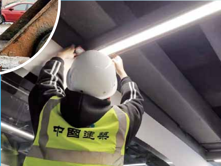
照明设施安装。
