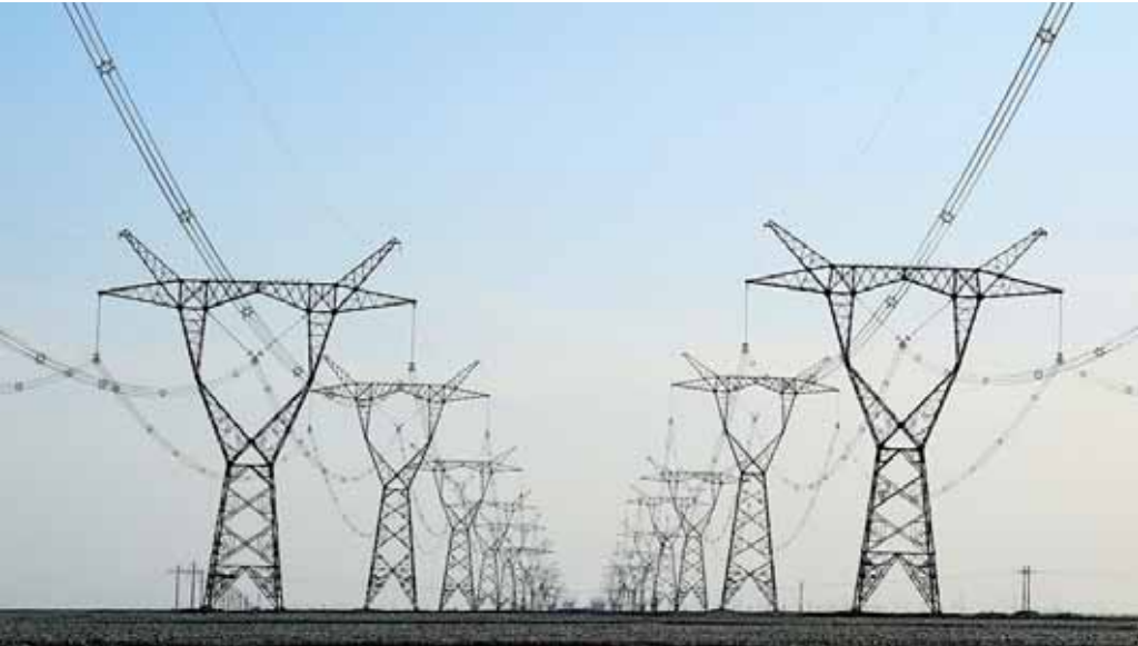
衡阳对口支援县吐鲁番市鄯善县西电东输超高压线路。
