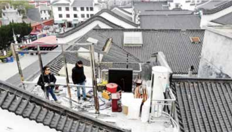
无人机航拍下，岳庙广场屋顶违建部分正在有序拆除。
