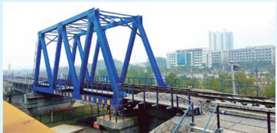
路桥综合实训基地。
