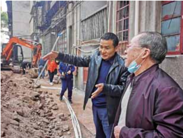
雁峰区干部群众关注挡土墙工程。
