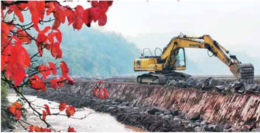
2021年,常宁市高标准农田建设项目共涉及全市7个乡镇38个行政村、8.1万亩,总投资约1.3亿元。项目的建成将对夯实该市农业基础设施、大力推广农业机械化作业、助力粮食增产起着重要作用。 ■通讯员 郭宜庚 摄
