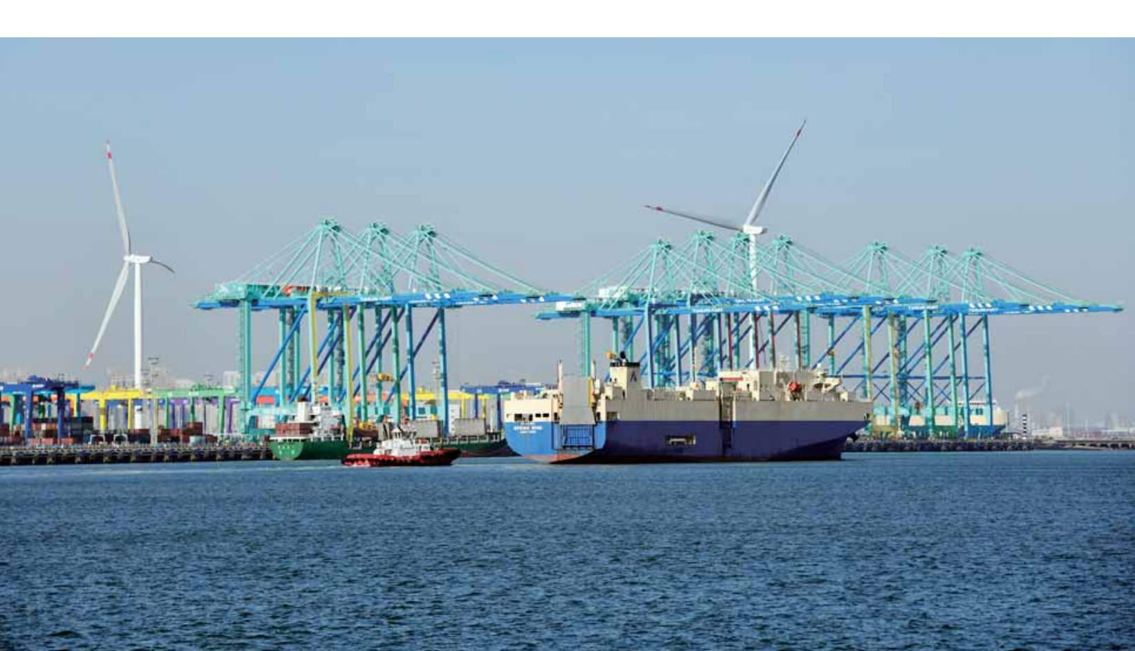
这是12月18日拍摄的天津港“智慧零碳”码头一景。当日，天津港年集装箱吞吐量首次突破2000万标准箱，创历史新高。据介绍，天津港今年新开通内外贸航线10条，同全球200多个国家和地区的800多个港口有贸易往来，其中与“一带一路”沿线港口贸易货物在总吞吐量中占比超过六成。
