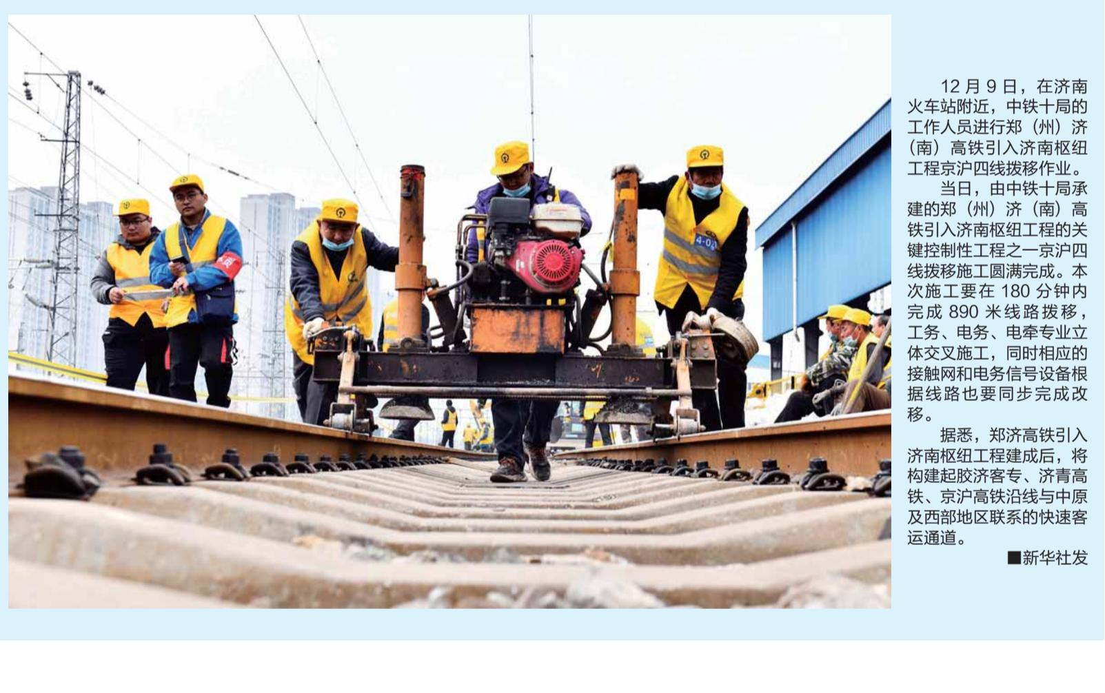
12月9日，在济南火车站附近，中铁十局的工作人员进行郑(州)济(南)高铁引入济南枢纽工程的关键控制性工程之一京沪四线拨移作业。
