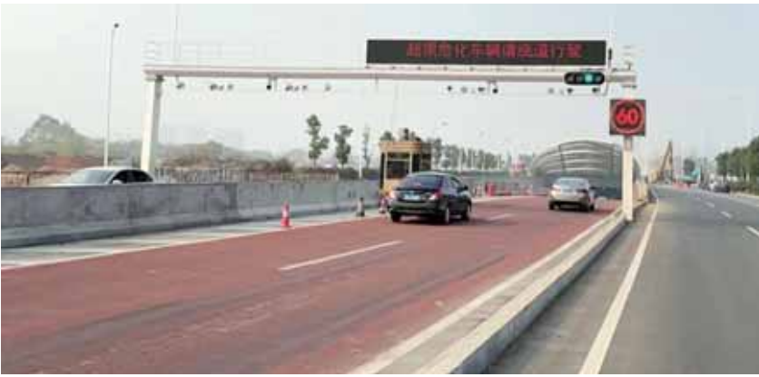
安装在隧道入口处的限速标志及可变门式情报板。
