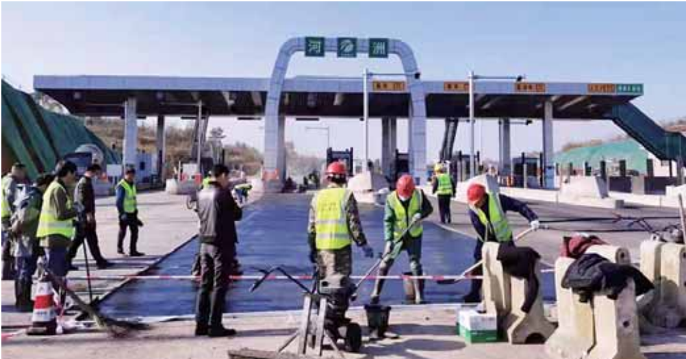
常祁高速河洲收费站施工进入扫尾阶段。
