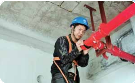
安装消防支架。
