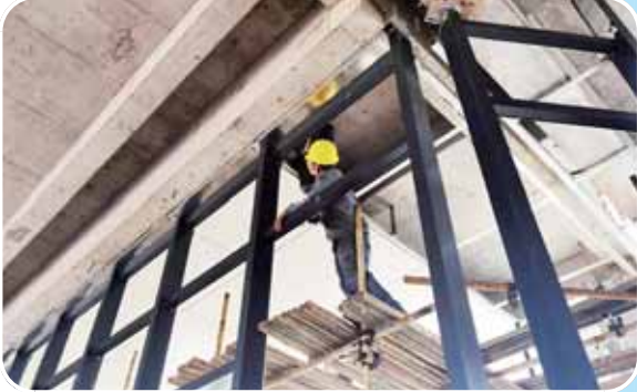
安装铝板吊顶。
