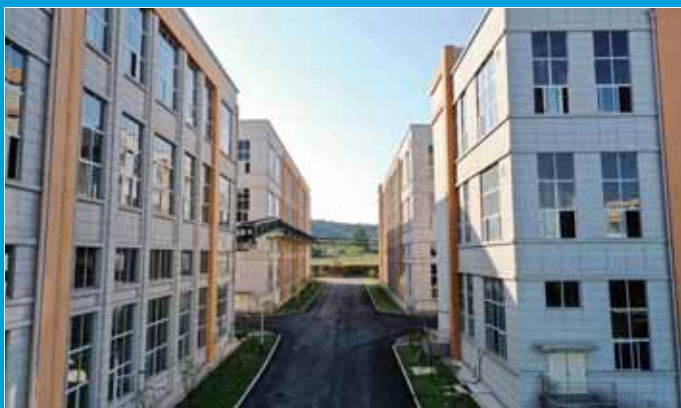
标准厂房之间的道路已经硬化。
