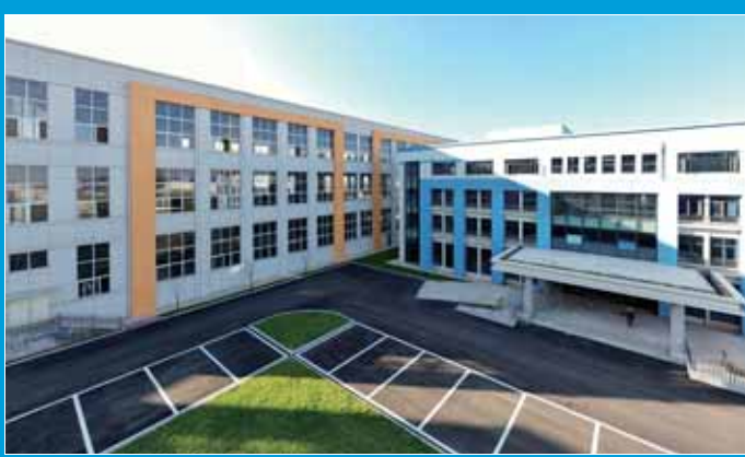
配套的办公大楼颇具气势。
