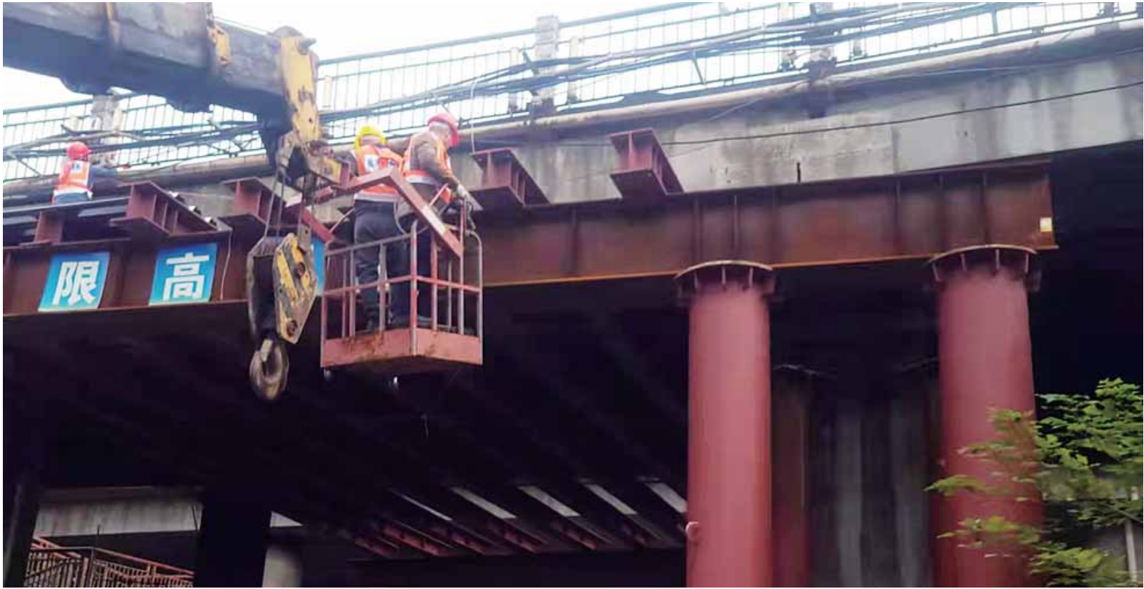
历经一个月的艰苦施工,湘江公铁大桥道口段安装防坠棚施工作业已全面进入扫尾阶段,预计本月底全面完工。
