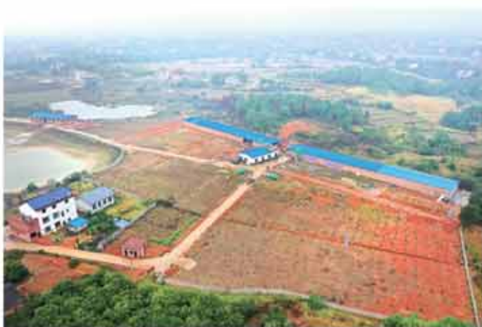
正在建设的自动化标准鸡养殖栏舍。
