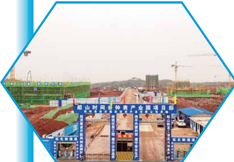
船山时间谷钟表产业园项目未来主入口。
