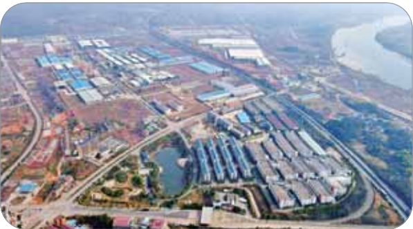
建设中的新能源汽车产业项目。
