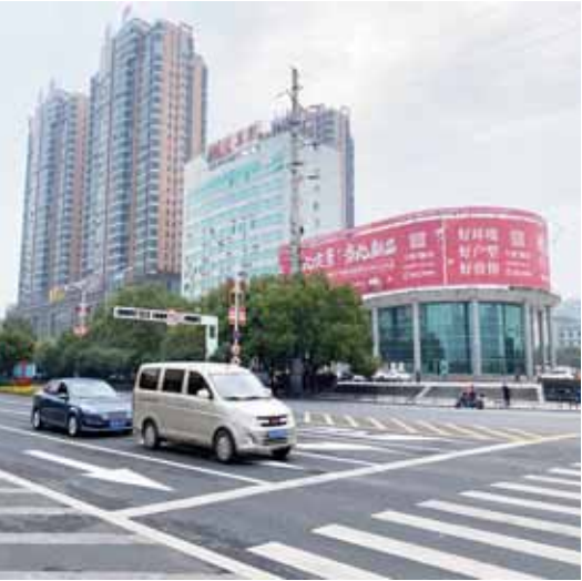
解放大道与蒸水南路十字路口东西双向均增加了一条左转弯道。
