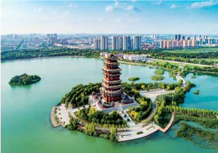
黄河楼拔地而起，成为黄河下游一座标志性建筑。滨州正汇聚黄河新动能，奏响生态保护和高质量发展的黄钟大吕。
