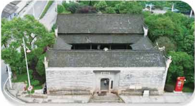
航拍湘南学联旧址
