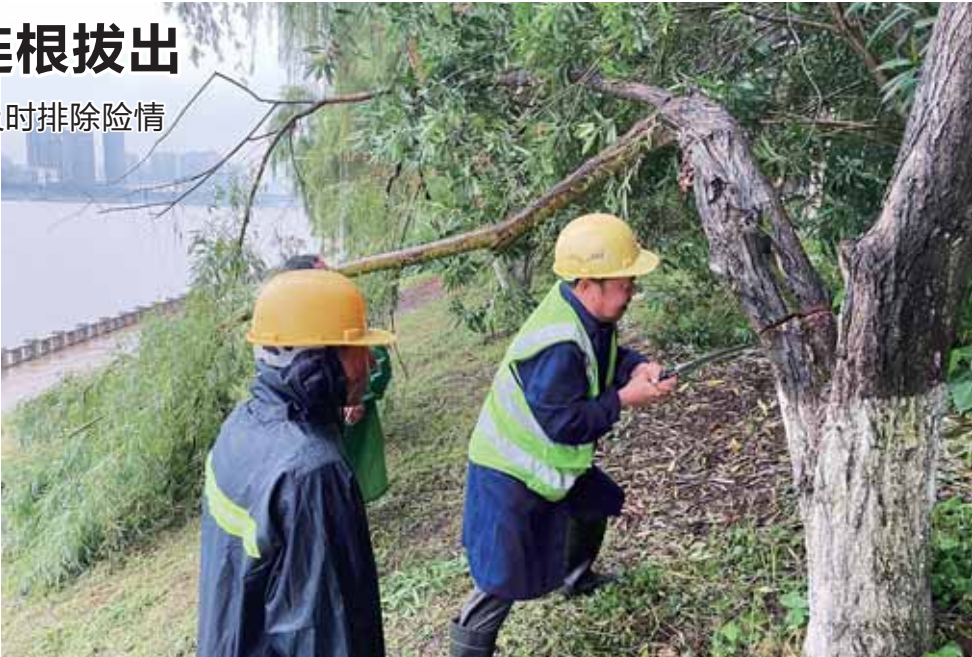
抢险队员对“骨折”的树枝及时进行处理
