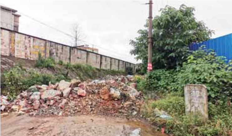
堆满建筑垃圾
