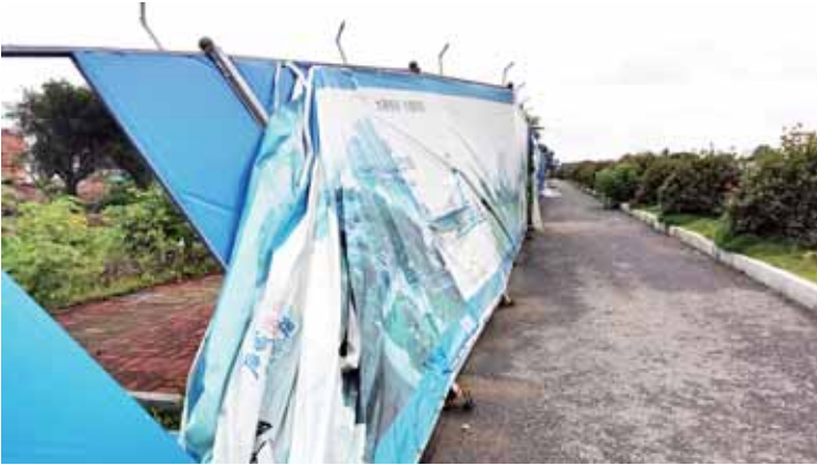
建筑围挡严重破损
