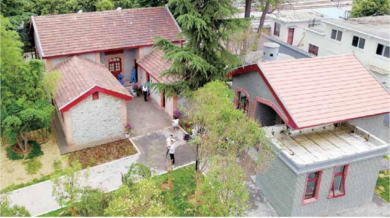
改造提升前的中共洛阳组纪念馆
