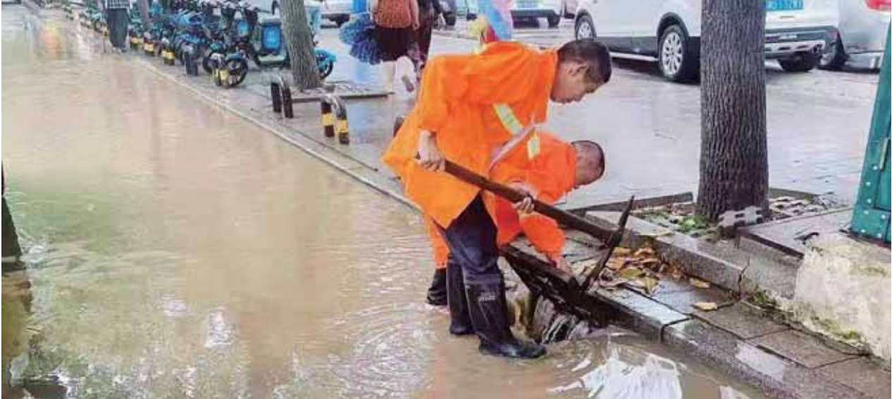
抢险队员掀开井盖,加快排除积水。
