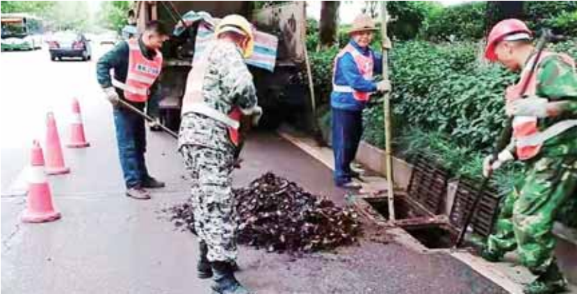
施工人员对雨水井开展清淤作业
