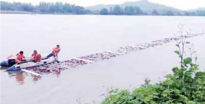
施工人员正加紧安装警示灯
