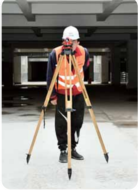
地下室地坪施工测量放线
