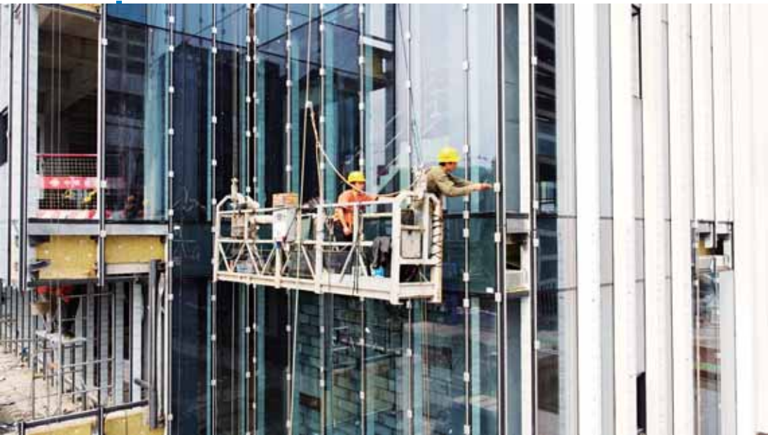
安装幕墙玻璃
