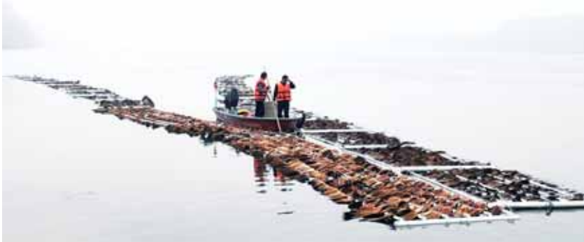
施工人员正在江中投放人工鱼巢
